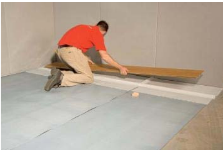
Eerste parketdeel of -baan wordt op hulpfolie aangebracht.
