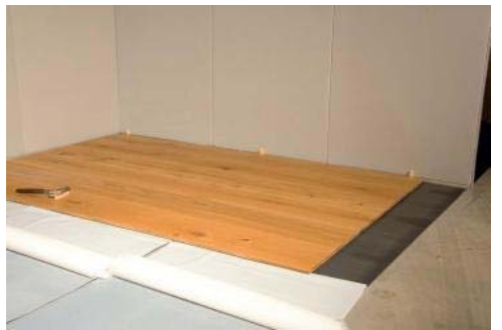
Vanaf nu kunnen meerdere delen tot naadloos worden gelegd, alvorens de beschermlaag tussen hout en Elastilon te verwijderen.
