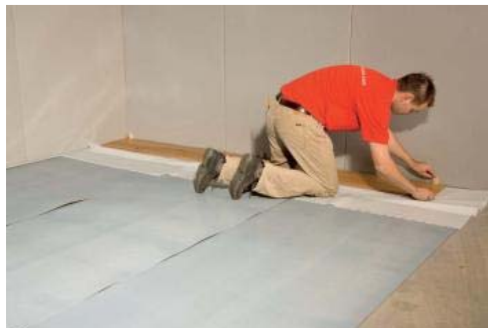
Afstandsklossen tussen muur en parketvloer worden aangebracht.
