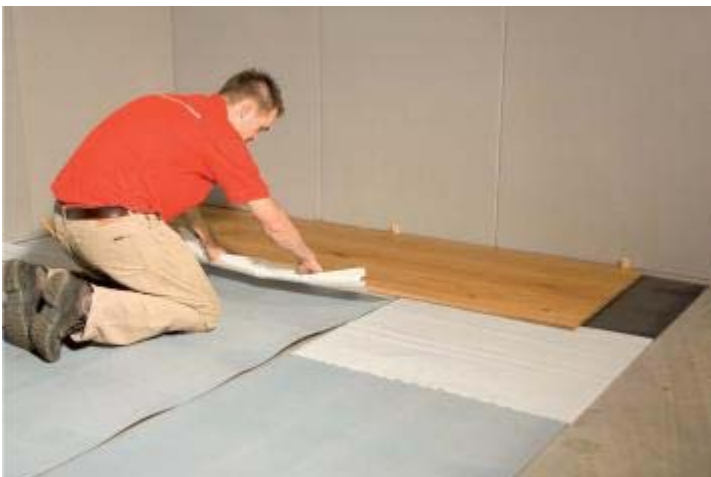
Tweede parketdeel in het eerste tot mooi sluitend (naadloos) aangedreven, waarna de hulpfolie tussen Elastilon en parketdeel(en) verwijderd wordt. Er wordt nu verder gewerkt met de aan Elastilon eigenlijke beschermlaag.
