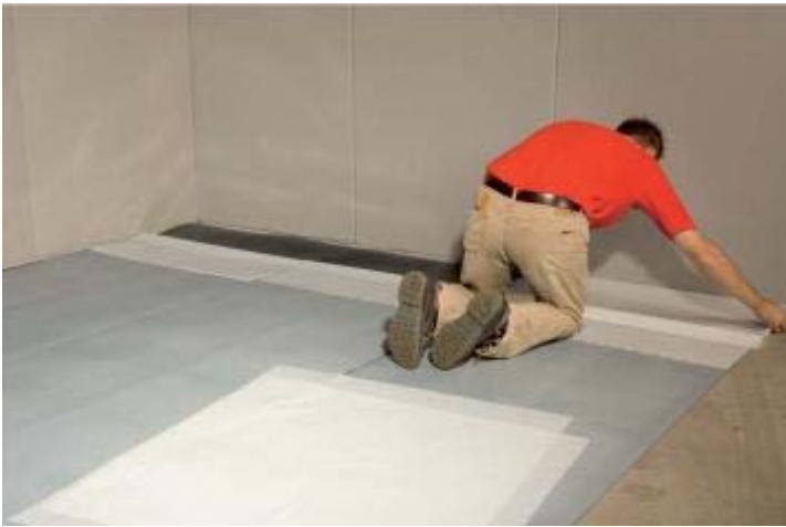
Hulpfolie met vouwzijde naar de muur zorgvuldig op vrijgekomen kleeflaag leggen.
