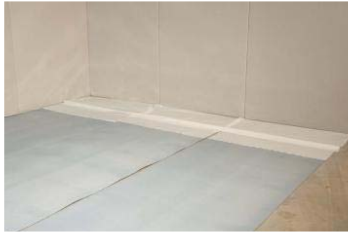
Hulpfolie aangebracht.
